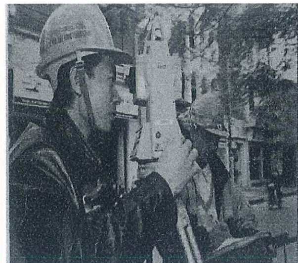
Đo đạc khảo sát địa hình
