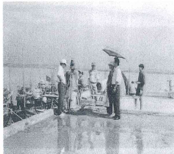
Đo đạc khảo sát địa hình
