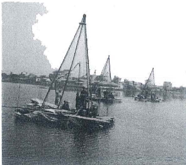
Khoan KSDC công trình cầu
